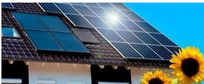
Figure 19: Capteur solaire thermique (chauffage de l'eau) et panneau photovoltaïque (électricité).
