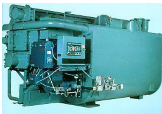
Figure 11: Groupes frigorifiques à absorption
